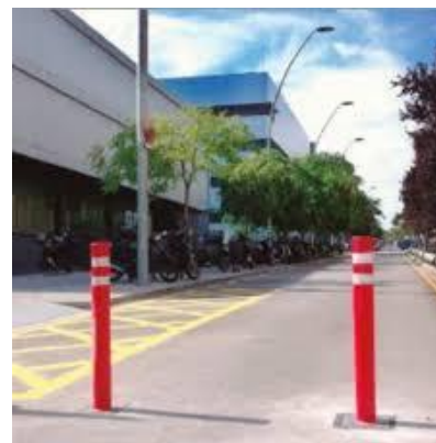
Figura 3. Fita de protecció mecànica
